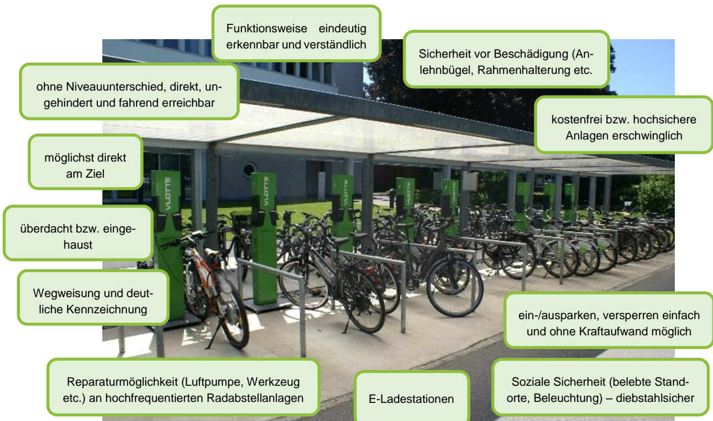
Abbildung 10: Best Practice Beispiel für Radparken mit hohen Qualitätsansprüchen (Land Steiermark 2008; Meschik 2008; Bildquelle: verkehrplus – Bregenz)
