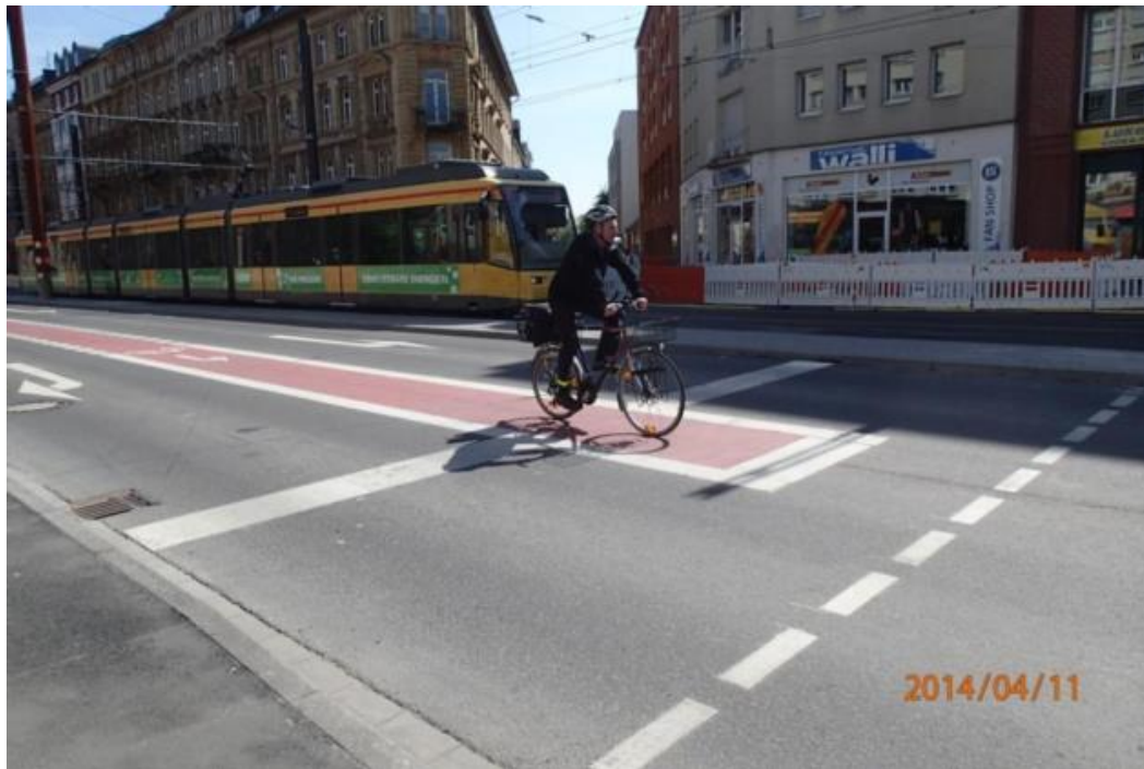
Abbildung 70: Best Practice Beispiel für eine optimale Bodenmarkierungs-Lösung im Bereich von Knotenpunkten: Vorgezogene und farblich hervorgehobene Aufstellfläche für Radfahrer vor Kreuzung (Quelle: verkehrplus -Karlsruhe)
