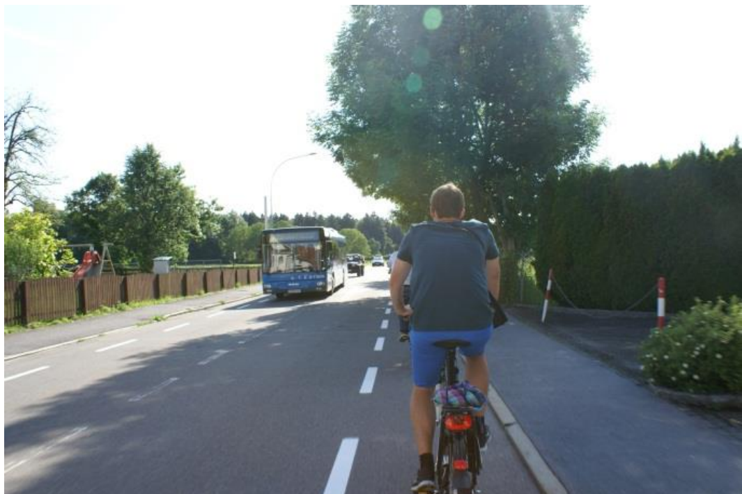
Abbildung 73: Best Practice Beispiel für eine optimale Bodenmarkierungs-Lösungen abseits von Knotenpunkten: Einfacher Mehrzweckstreifen (Quelle: verkehrplus - Bregenz)
