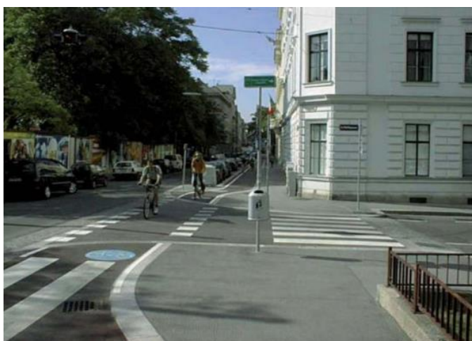
Abbildung 12: Von der Fahrbahn nicht abgesetzte Radfahrerüberfahrt (Quelle: FSV 2014)
