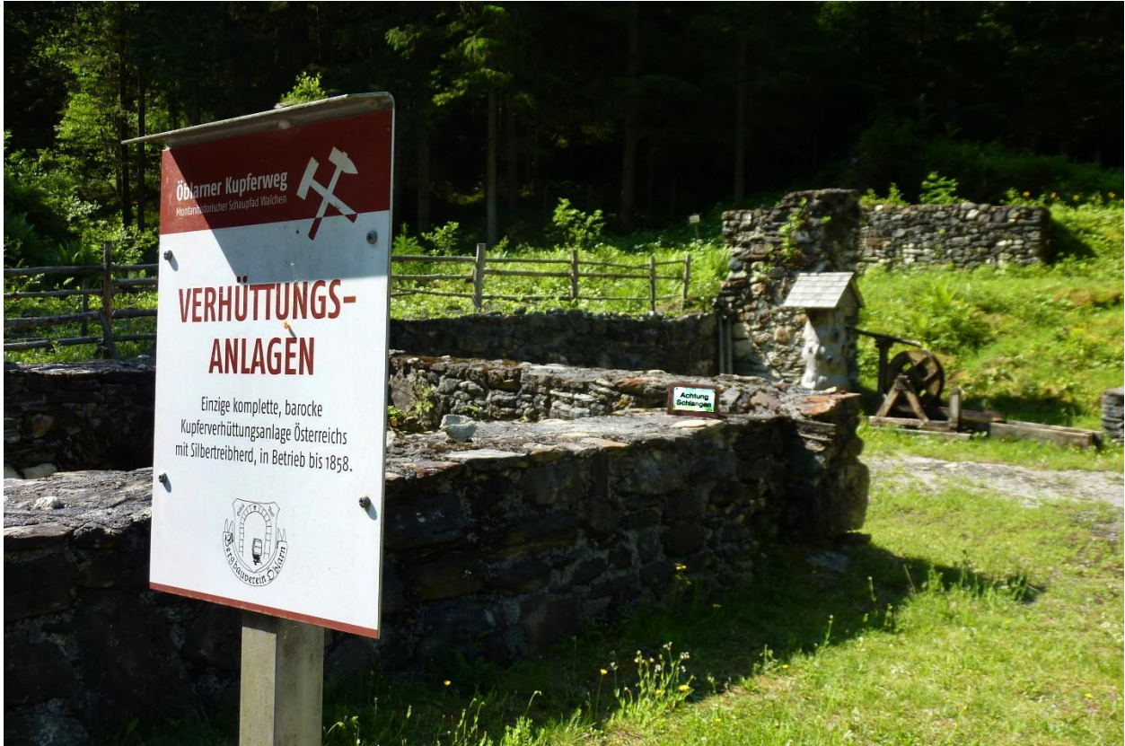
Verhüttungsanlage in der Walchen bei Öblarn (2017).
