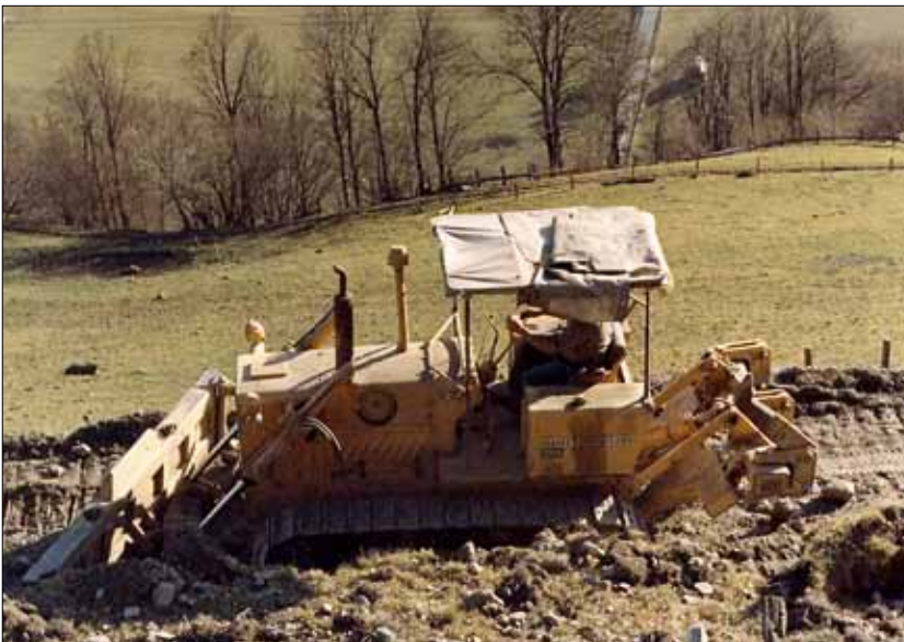
Erste Baumaschinen wurden ab Mitte der 1950er-Jahre eingesetzt. Der Straßenbau erfuhr durch die technischen Neuerungen einen Boom.
