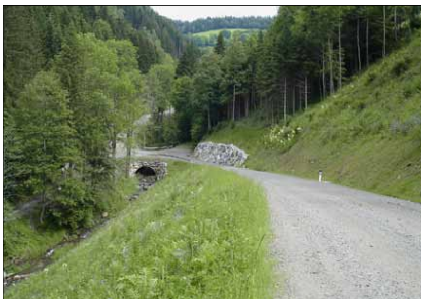
Beispiel für eine naturnahe Bauweise mit einem Wasser-Durchlass. Diese Methode erfordert keinen Brückenbau.
