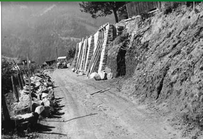
Straßenbau seinerzeit: Im hügeligen Gebiet mussten die Stützmauern mühsam händisch errichtet werden.
