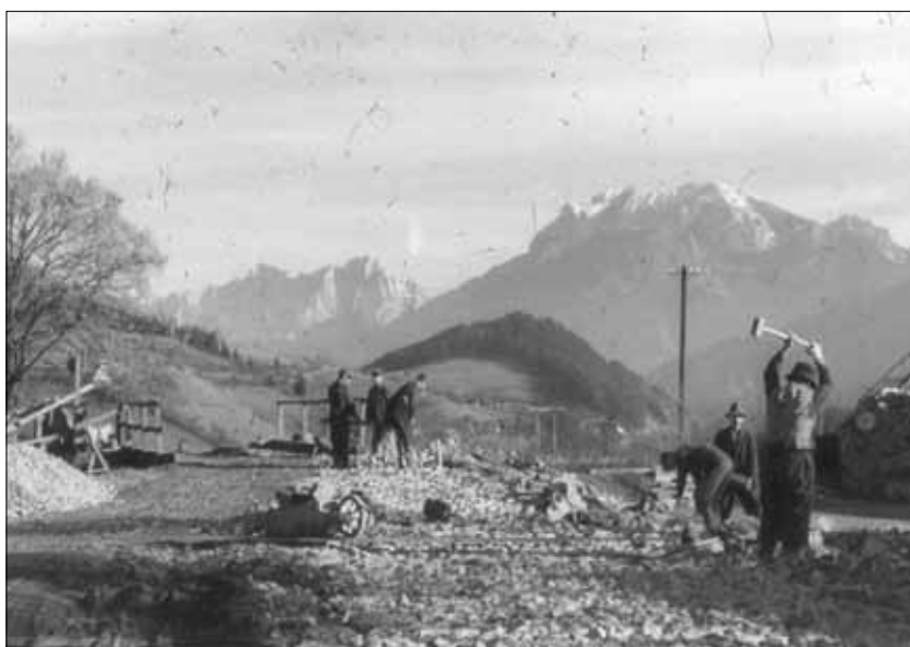
Eine Arbeitspartie bei der Herstellung des Grundbaues. Die Steine wurden in Packlagenbauweise untereinander verkeilt.
