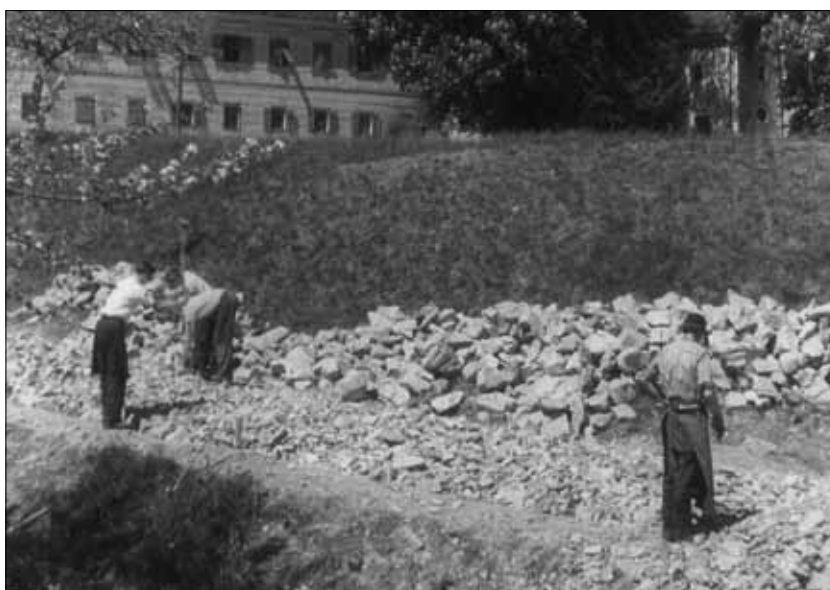
Befestigung eines vormaligen Lehmweges in Safenau (Hartberg-Umgebung). Der Wegebau diente auch als Arbeitsbeschaffung für die Bewohner der ländlichen Gebiete.
