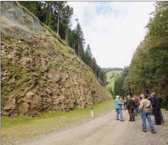
Nach Katastrophenschäden waren teils umfangreiche Neuerrichtungen und Sicherungsmaßnahmen erforderlich.
