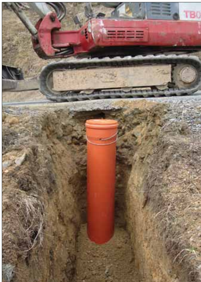
Einbau einer Temperaturmessstation: Die Messdaten dienen als Grundlage für die Achslastbeschränkungen ländlicher Straßen während der Frosttauperiode. Den Einbau kann man entweder während des Straßenneubaus oder nachträglich durch seitliches Einbohren durchführen.
