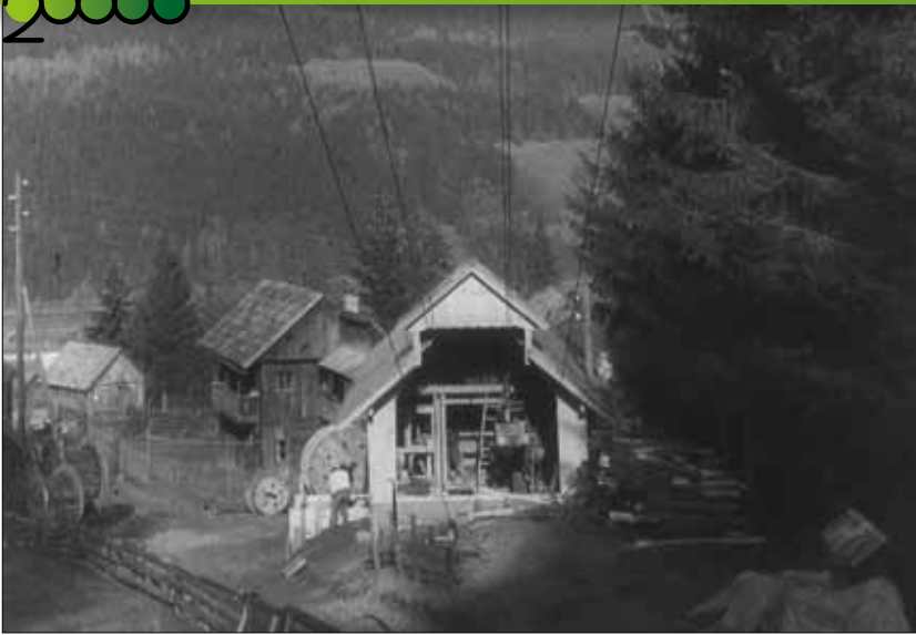
Materialseilbahn in der Gemeinde Haus im Ennstal. Neben den Güterwegen wurden auch derartige Transportmittel gefördert und errichtet.
