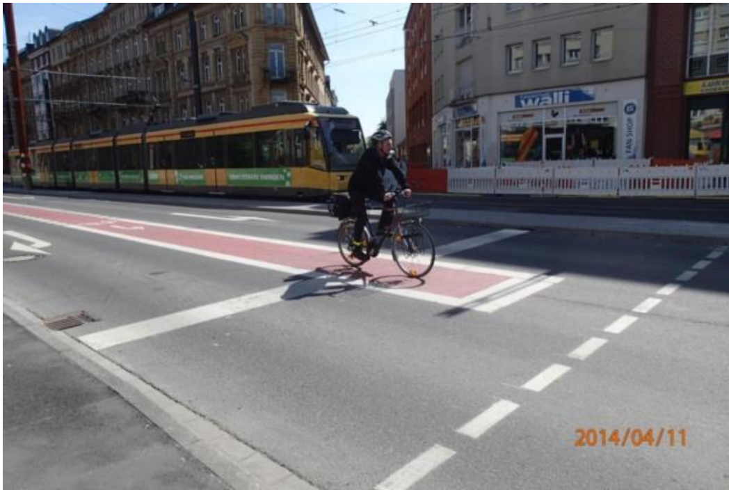
Abbildung 77: Best Practice Beispiel für eine optimale Bodenmarkierungs-Lösung im Bereich von Knotenpunkten: Vorgezogene und farblich hervorgehobene Aufstellfläche für Radfahrer vor Kreuzung (Quelle: verkehrplus -Karlsruhe)
