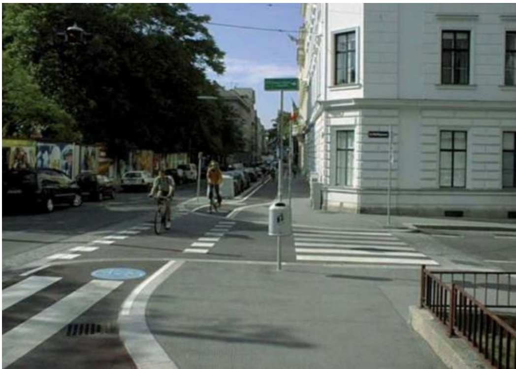
Abbildung 78: Best Practice Beispiel für eine optimale Bodenmarkierungs-Lösung im Bereich von Knotenpunkten: Von der Fahrbahn nicht abgesetzte Radfahrerüberfahrt (Quelle: FSV 2014)
