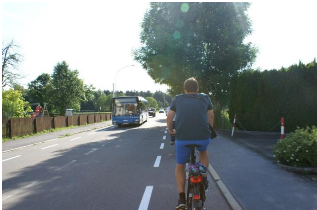
Abbildung 80: Best Practice Beispiel für eine optimale Bodenmarkierungs-Lösungen abseits von Knotenpunkten: Einfacher Mehrzweckstreifen (Quelle: verkehrplus - Bregenz)
