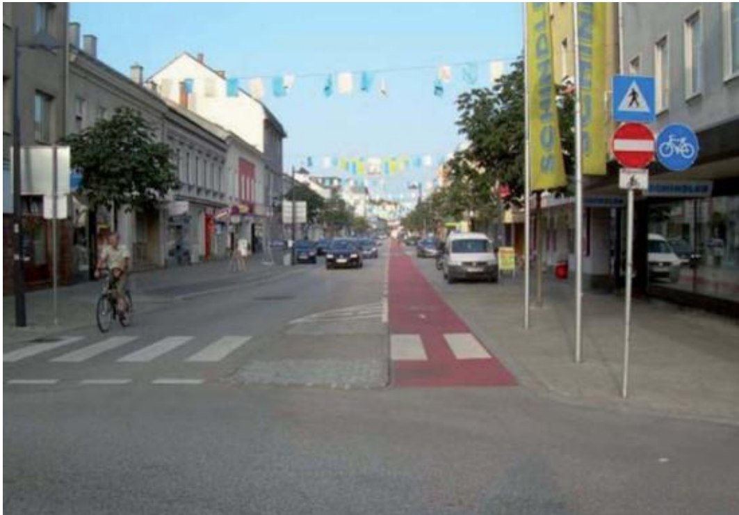
Abbildung 81: Best Practice Beispiel für eine optimale Bodenmarkierungs-Lösungen abseits von Knotenpunkten: Baulich getrennter Beginn eines farblich hervorgehobenen Radfahrstreifens gegen die Einbahn neben Parkstreifen (Quelle: FSV 2014)
