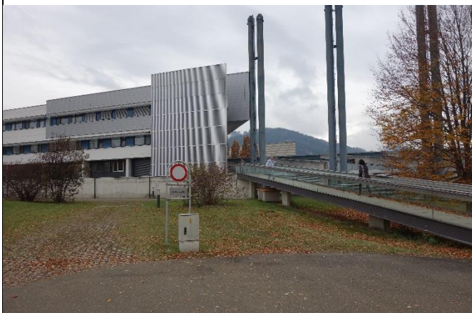
Abbildung 56: LKH Bruck / Mur
