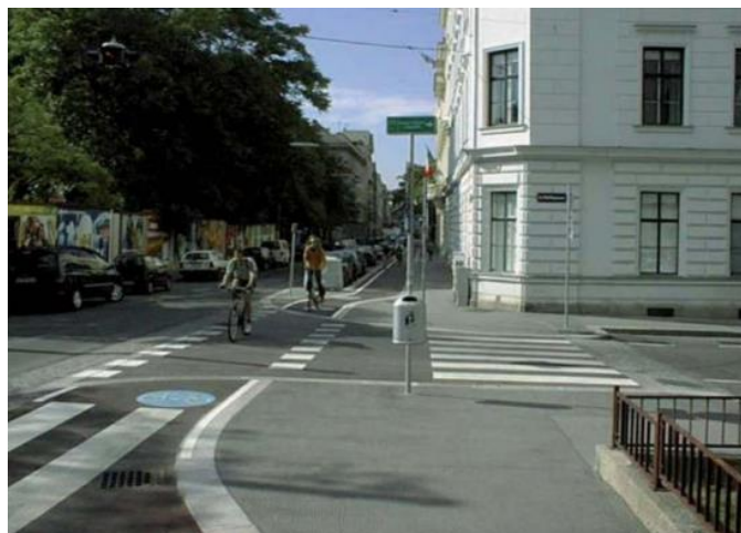
Abbildung 12: Von der Fahrbahn nicht abgesetzte Radfahrerüberfahrt (Quelle: FSV 2014)
