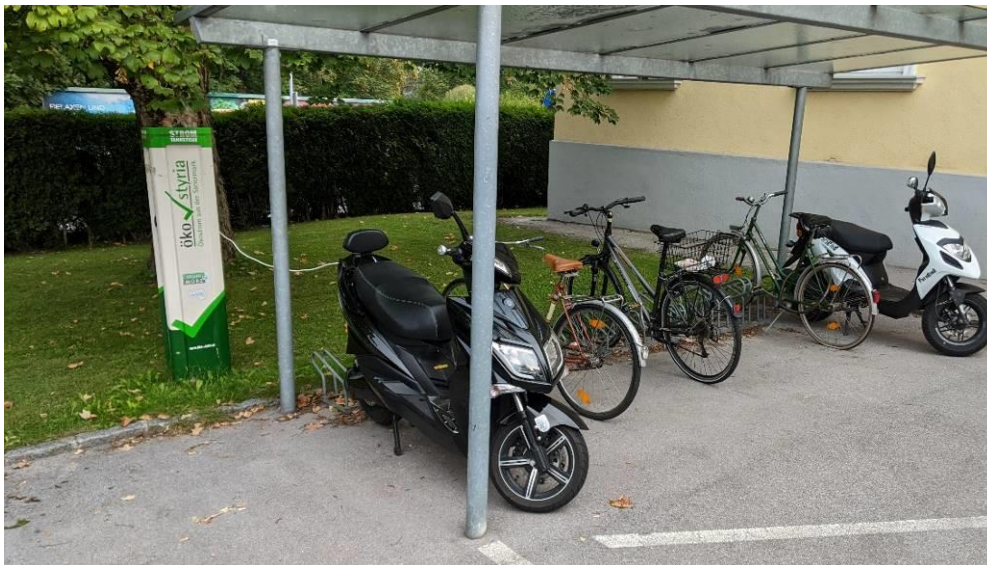
Foto 2: E-Ladestation bei überdachter Radabstellanlage beim Landeskrankenhaus
