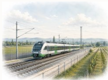
Ausbau steirische Westbahn
